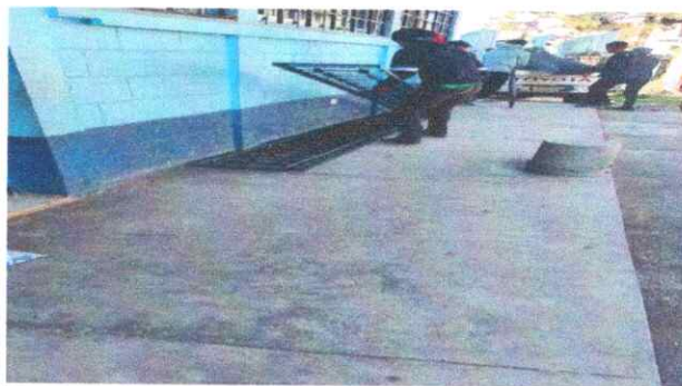
2. sustitucion de balcones de metal.
