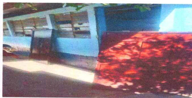
4. Sustitucion de puertas de metal.
