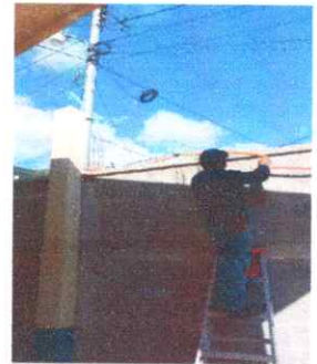
8. Acometida eléctrica y la alimentación al centro de carga.
