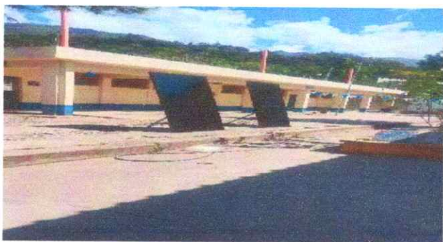
3. Reparacion consistente en cepillado, lijado y pintaado de puertas de metal.
