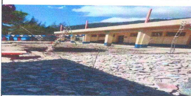
5. Reparacion de piso, torta de concreto.
