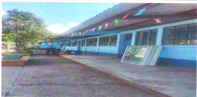
1. Sustitucion de ventana de metal mas vidrio.
