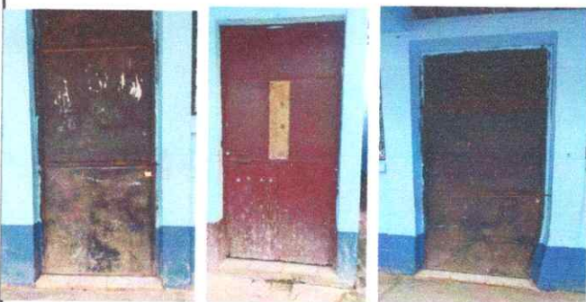
3. Reparacion consistente en cepillado, lijado y pintaado de puertas de metal.
