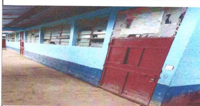
4. Sustitucion de puertas de metal.
