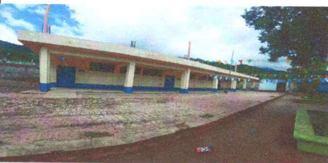
5. Reparacion de piso, torta de concreto.
