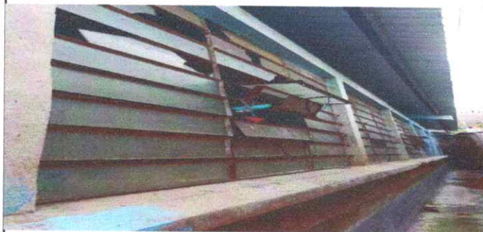
1. Sustitucion de ventana de metal mas vidrio.
