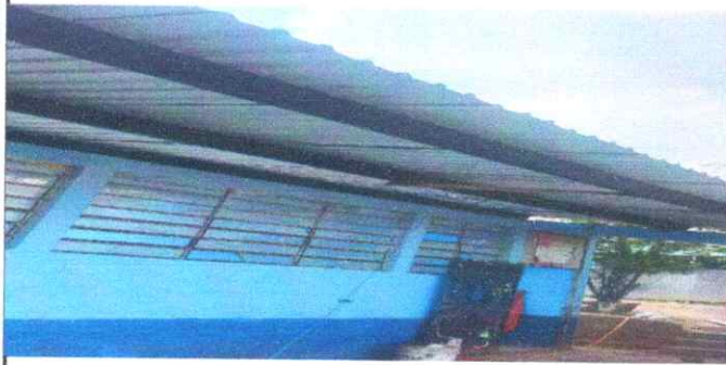
7. Reparación eléctrica, instalación de unidades luz, unidades fuerza, tableros, flipones.
