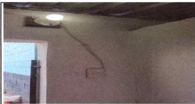
Foto 5. Reparación de sistema electrico en baños
