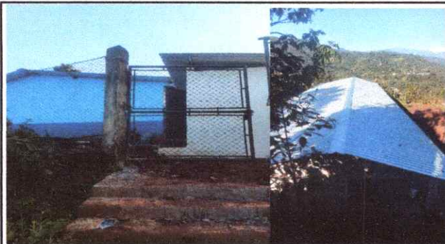
Foto1: Sustitución de lamina por lamina troquelada Maxalum
