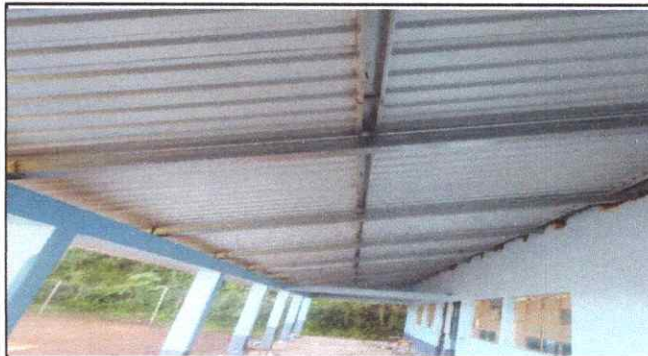
Foto 2: Sustitución de madera por estructura metalica.
