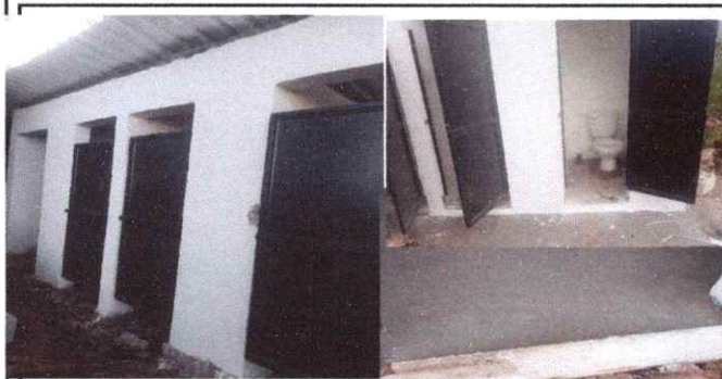
Foto 3: Reparación de paredes en servicios sanitarios y accesorios
