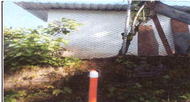
Foto 4: Reparación de drenaje
