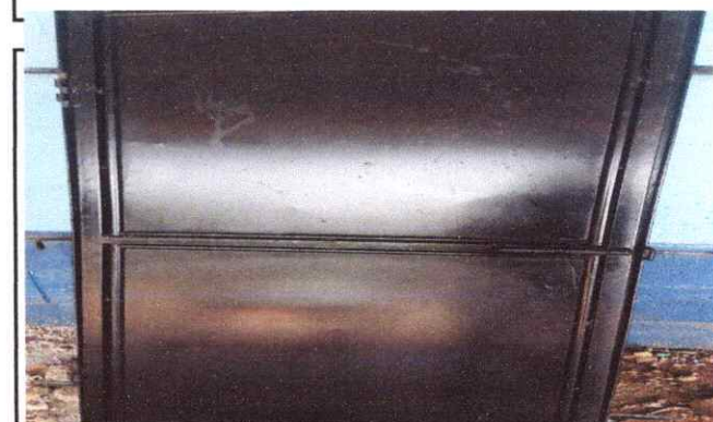
Foto 6: Sustitución de puertas y reparación
