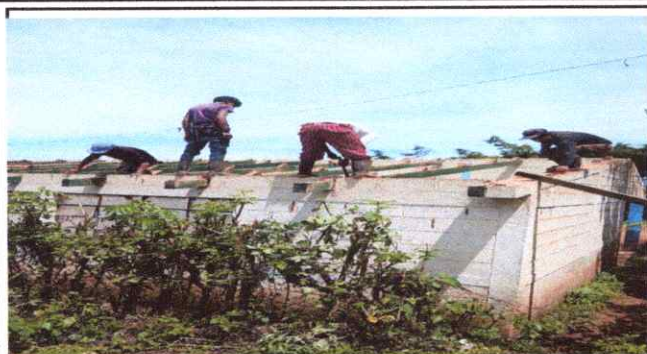
Foto1: Sustitución de lamina por lamina troquelada Maxalum
