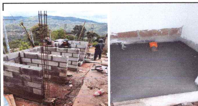
Foto 3: Reparación de paredes en servicios sanitarios, accesorios y Piso
