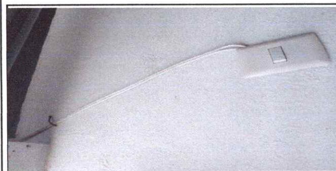
Foto 5. Reparación de sistema electrico en baños
