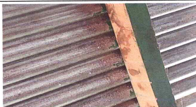
Foto 2: Sustitución de madera por estructura metalica.
