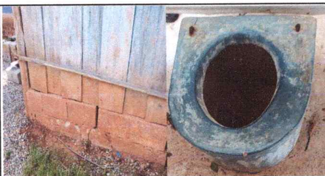
Foto 3: Reparación de paredes en servicios sanitarios y accesorios
