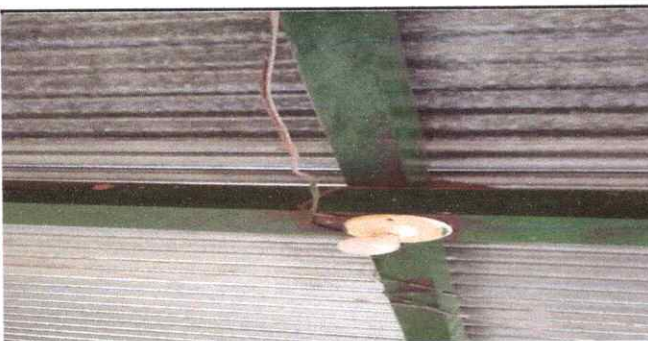
Foto 5. Reparación de sistema electrico en baños
