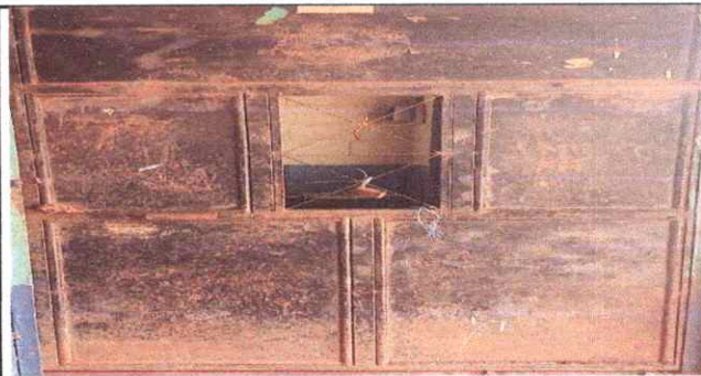
Foto 6: Sustitución de puertas
