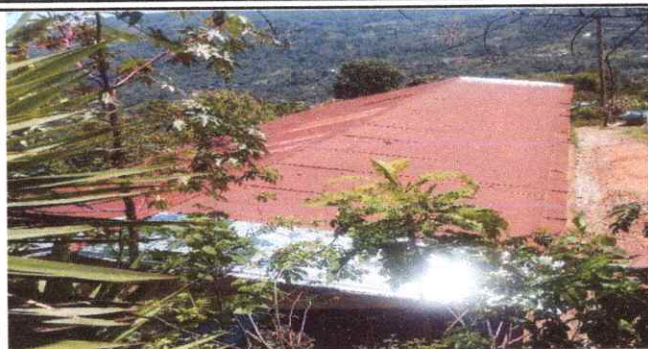
Foto1: Sustitución de lamina por lamina troquelada Maxalum
