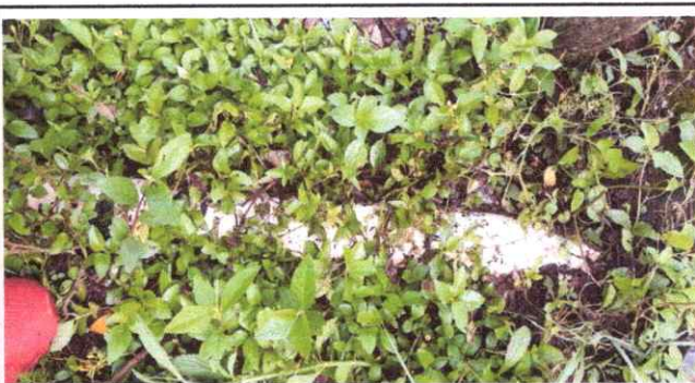
Foto 4: Reparación de drenaje
