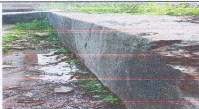
Foto No. 3: Reparación de muro perimetral.
