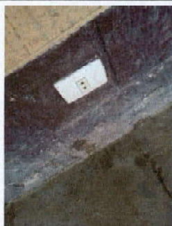
Foto 5: Las tomas de corriente están dañados, se necesita sustitución
