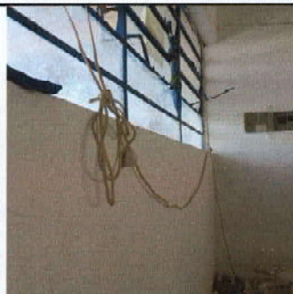
Foto 6: El cableado eléctrico está en mal estado, se necesita cambio
