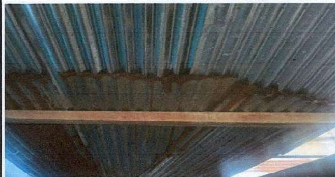
Foto 2.1: Sustitución de soporte de madera por soporte de metal
