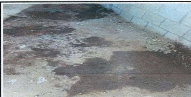
Foto 5.1: Mejoramiento de piso de tierra por concreto
