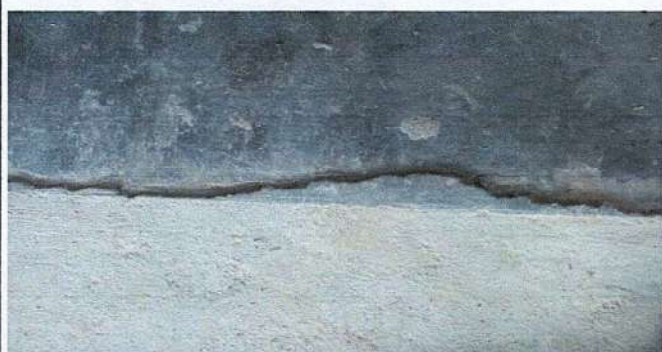
Foto 5.2: Sustrucción de torta de concreto por piso de granito.
