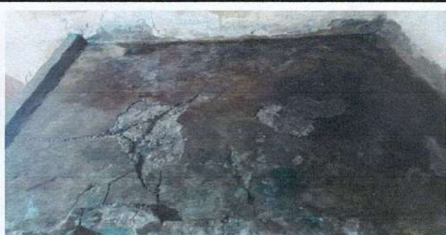
Foto 8.3: Reparación de azulejo en muebles de cocina
