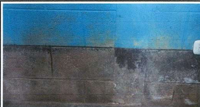
Foto 6.1: Pintura en muros exteriores e interiores
