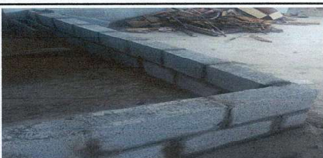
Foto 4.1: Mejoramiento de ventanas de metal en cocina
