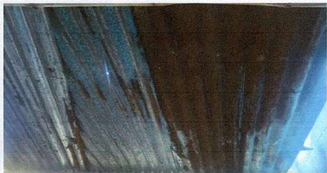
Foto 1.1: Sustitución de lámina por lámina troquelada.
