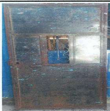
Foto 3.1: Sustitución de puerta
