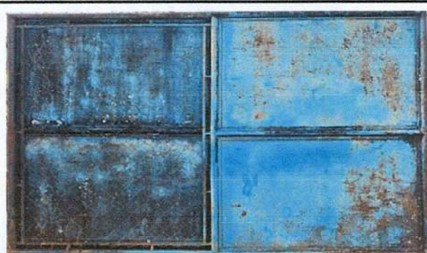
Foto 3.2: Sustitución de portón
