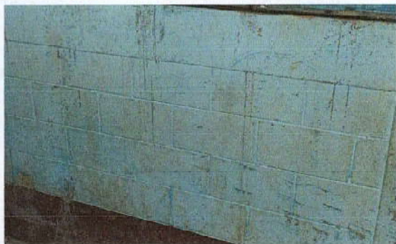
Foto 7: Pintura en muros exteriores e interiores
