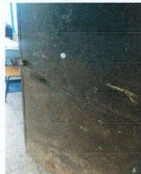
Foto 8: Mejoramiento de puertas
