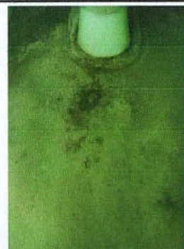
Foto 10: Mejoramiento de piso Antideslizante
