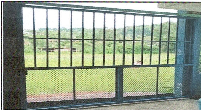
Foto 3: SUSTITUCIÓN DE PORTÓN DE METAL INSTALADO
