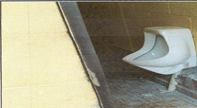
Foto7: SUSTITUCIÓN DE MINGITORIO INSTALADO
