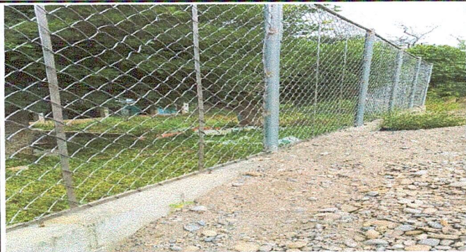
Foto 9: REPARACIÓN DE TUBO HG Y MALLA GALVANIZADA FINALIZADA
