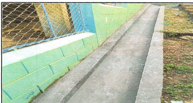
Foto 5: REPARACIÓN DE CUNETA DE CONCRETO TERMINADO
