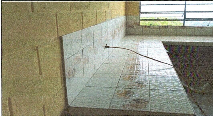
Foto 13: REPARACIÓN DE AZULEJO EN MUEBLES DE COCINA INSTALADO
