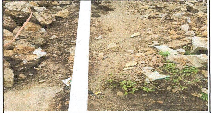
Foto 8: SUSTITUCIÓN DE TUBERÍA PVC LÍNEA PRINCIPAL AGUAS NEGRAS INSTALADA
