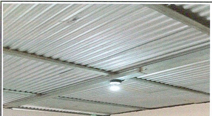
Foto 2: SUSTITUCIÓN DE ESTRUCTURA DE SOPORTE DE MADERA POR METAL TERMINADO
