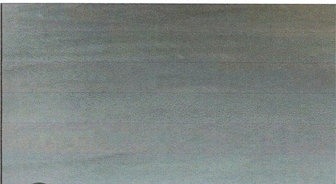
Foto 4: SUSTITUCIÓN DE PISO DE TORTA DE CONCRETO TERMINADO
