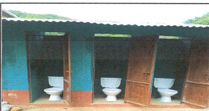
Foto 6: SUSTITUCIÓN INODORO FINALIZADO
