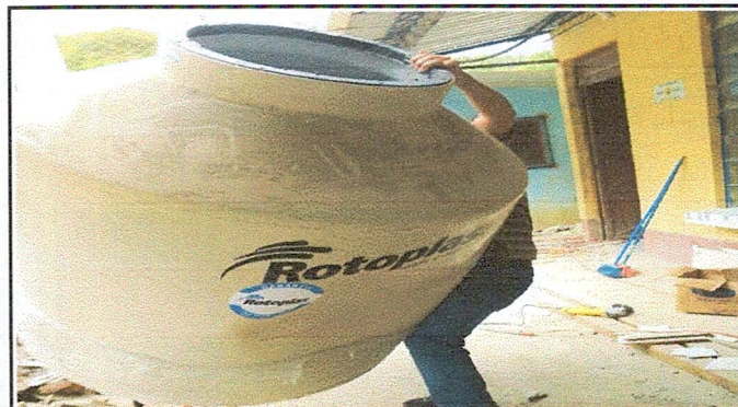
Foto 10: SUSTITUCIÓN DE DEPÓSITO DE AGUA 1100 LT EN PROCESO
