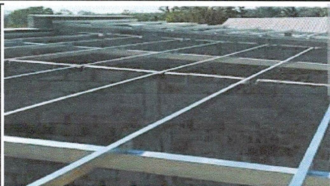
Foto 2: SUSTITUCIÓN DE ESTRUCTURA DE SOPORTE DE MADERA POR METAL EN PROCESO
