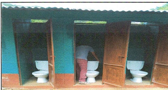
Foto 6: SUSTITUCIÓN INODORO EN PROCESO
