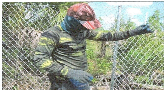
Foto 9: REPARACIÓN DE TUBO HG Y MALLA GALVANIZADA EN PROCESO
