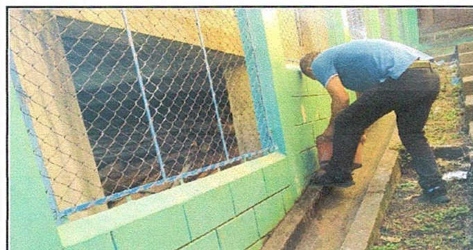
Foto 5: REPARACIÓN DE CUNETA DE CONCRETO EN REPARACIÓN
