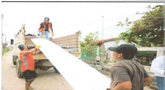
Foto1: SUSTITUCIÓN DE LÁMINA, POR LÁMINA TROQUELADA ALUZINC CALIBRE 26 EN PROCESO
