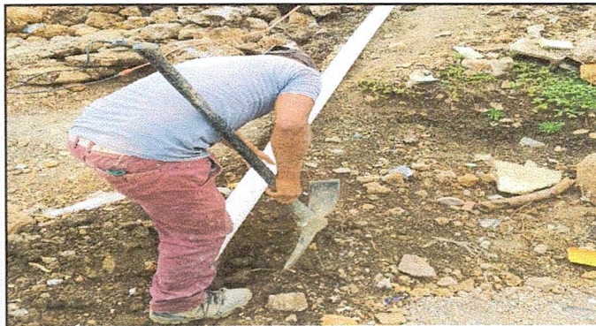
Foto 8: SUSTITUCIÓN DE TUBERÍA PVC LÍNEA PRINCIPAL AGUAS NEGRAS EN PROCESO
