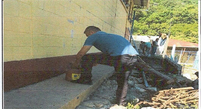
Foto 14: REPARACIÓN DE BANQUETAS DE CONCRETO EN PROCESO
