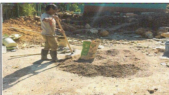
Foto 4: SUSTITUCIÓN DE PISO DE TORTA DE CONCRETO EN PROCESO
