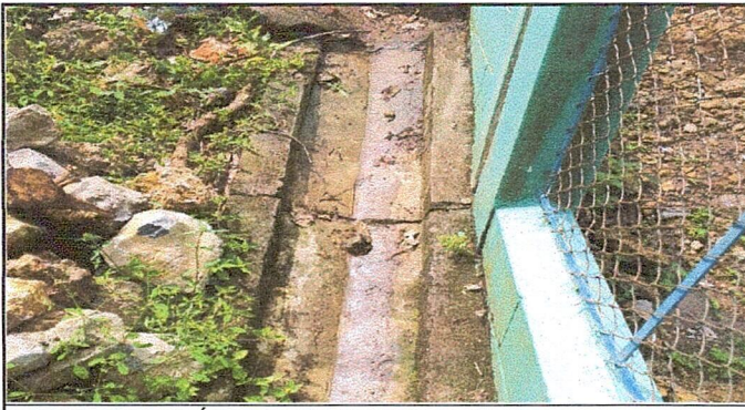
Foto 5: REPARACIÓN DE CUNETA DE CONCRETO
