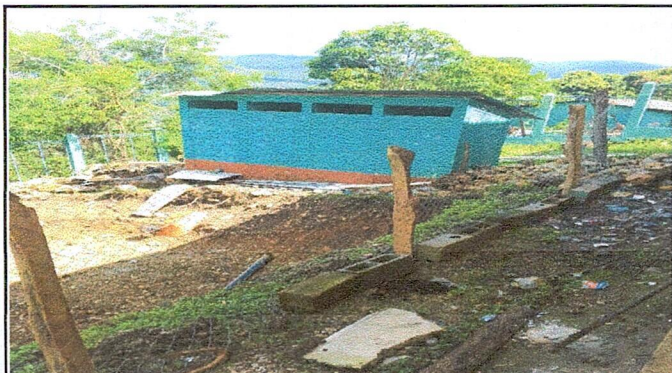
Foto 9: REPARACIÓN DE TUBO HG Y MALLA GALVANIZADA
