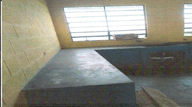
Foto 13: REPARACIÓN DE AZULEJO EN MUEBLES DE COCINA
