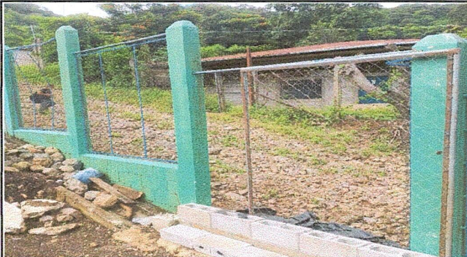
Foto 3: SUSTITUCIÓN DE PORTÓN DE METAL
