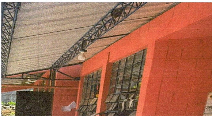
Foto 3: Sustitución de lamparas de tubo por bombillas Led
