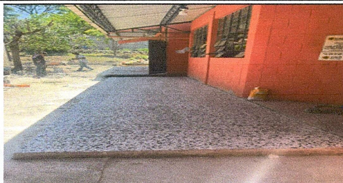
Foto 2: Sustitución de piso de granito en corredor de aulas
