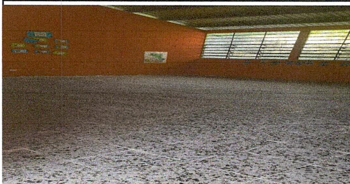
Foto1: Sustitución de piso de granito en 2 aulas
