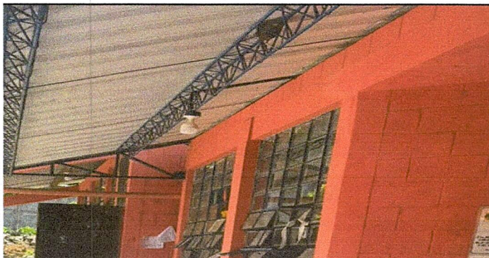
Foto 5: Sustitución de plafoneras
