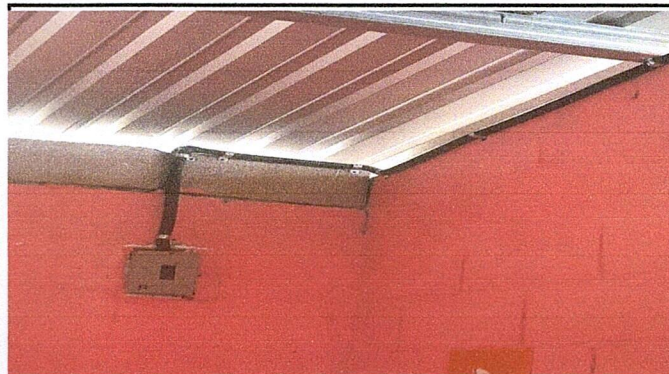
Foto 8: Sustitución de ducto eléctrico y accesorios
