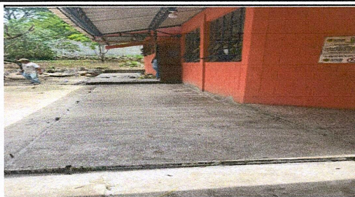
Foto 2: Sustitución de piso de granito en corredor de aulas
