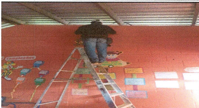
Foto7: Reparación de Cableado Eléctrico
