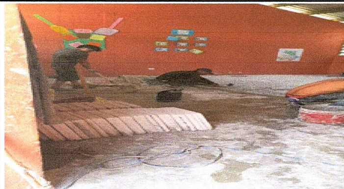
Foto1: Sustitución de piso de granito en 2 aulas
