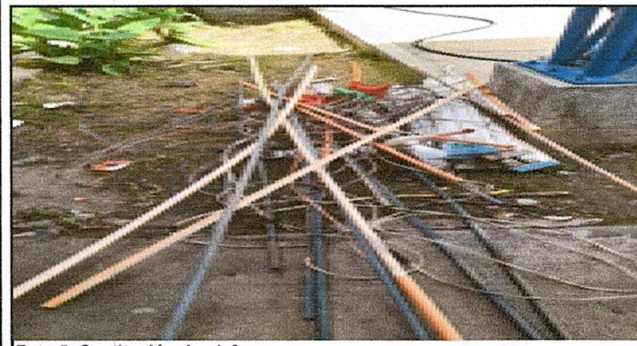
Foto 5: Sustitución de plafoneras
