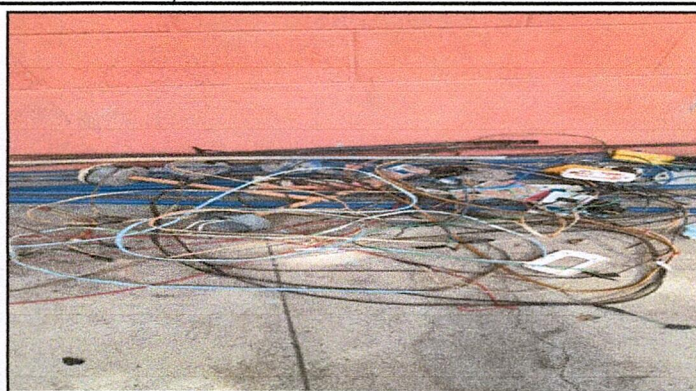
Foto 8: Sustitución de ducto Eléctrico y accesorios
