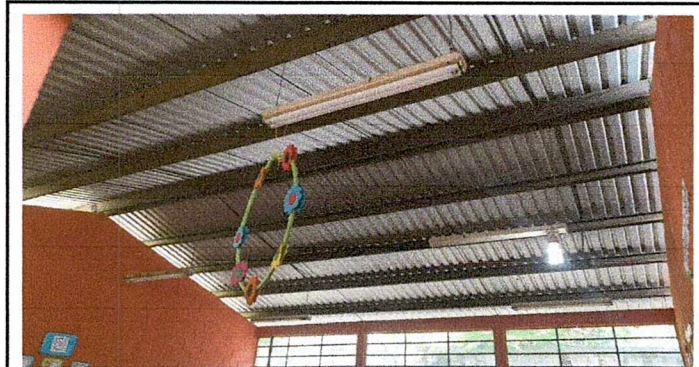
Foto 3: Sustitución de lamparas de tubo por bombillas Led
