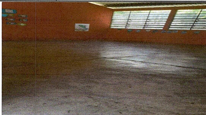
Foto1: Sustitución de piso de granito en 2 aulas
