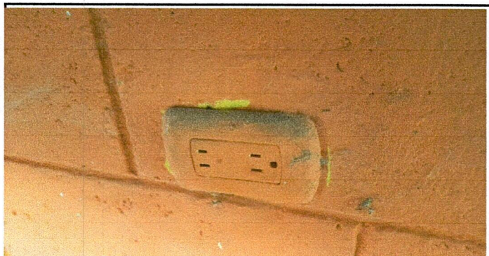
Foto 9: Sustitución de toma corrientes dobles
