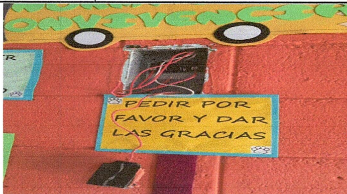
Foto 7: Reparación de Cableado Eléctrico
