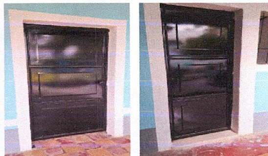
Foto 2: Instalación de puertas nuevas
