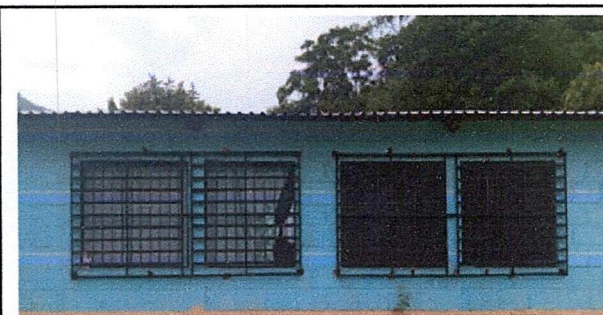
Foto 5: Balcon nuevo instalado
