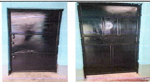
Foto 3: Mantenimiento finalizado a puertas de metal
