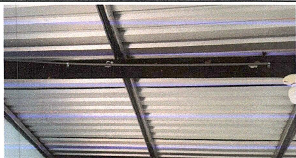
Foto 13: Reparación del ducto más accesorio y sistema eléctrico finalizado
