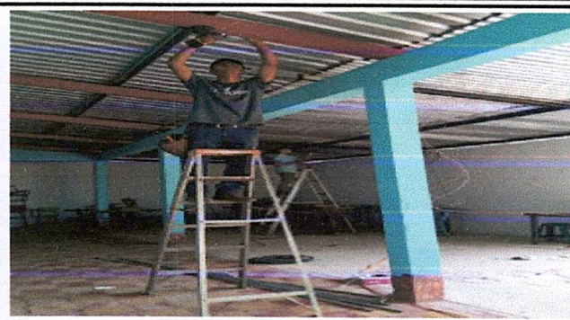
Foto 8: Momento en donde el electricista inicia con la conexión para las plafoneras.
