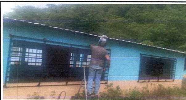
Foto 5: Momento en el cual se realiza la instalación de los nuevos balcones.
