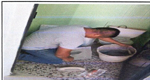
Foto 6: Sustrucción de piso en servicios sanitarios, colocación del piso de granito.
