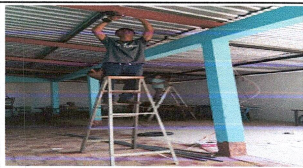
Foto 15: se trabaja en la instalacion de unidades del sistema electrico
