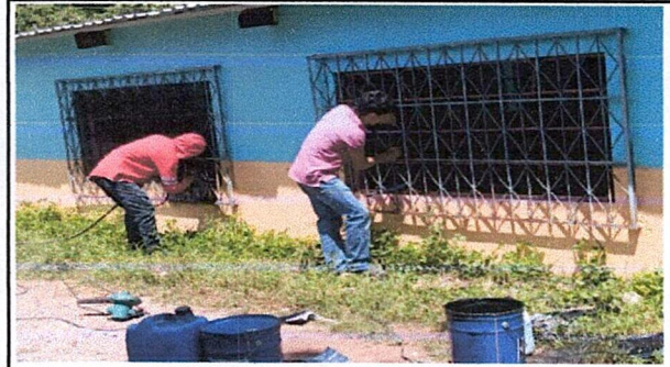
Foto 4: Mantenimiento de balcones, momento en el que inicia el lijado y pintado de balcones
