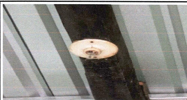
Foto 8: Sustrucción de plafonera por estar en malas estado.
