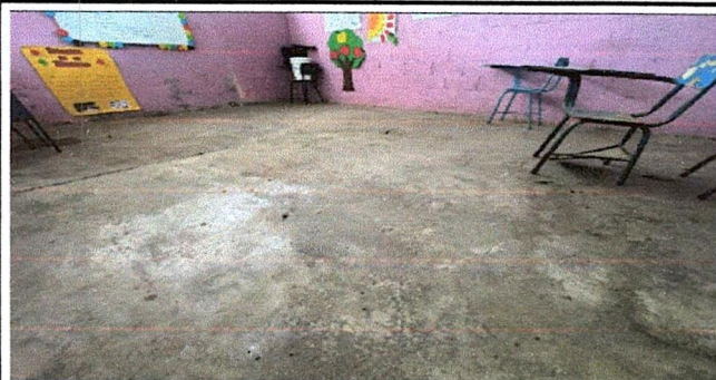
Foto 7: Sustrucción de piso de aula por estar en malas condiciones.
