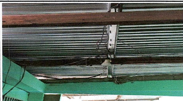
Foto 13: Sustitución de cableado eléctrico.
