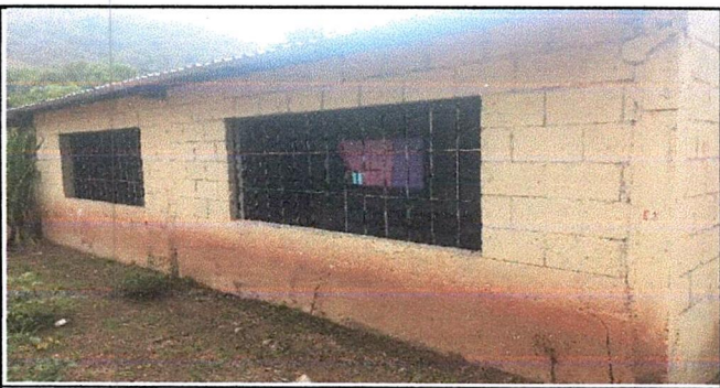
Foto 5: Sustrucción de balcones por estar en malas condiciones.
