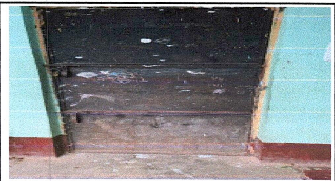
Foto 3: Mantenimiento a estructura de puerta por deterioro.
