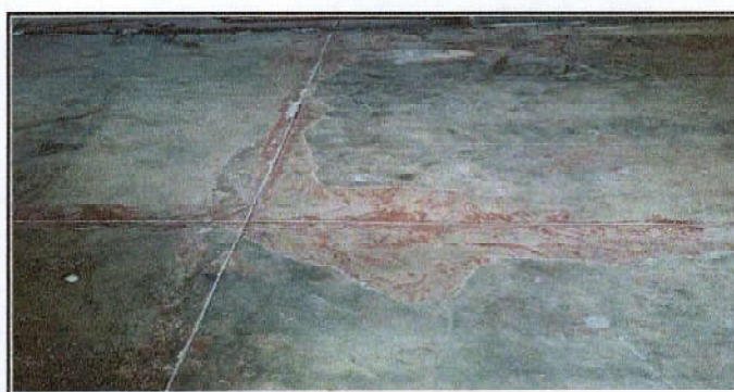
Foto 6: Sustitución de piso
