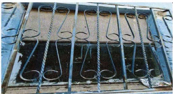
Foto 5: Sustitución de ventana
