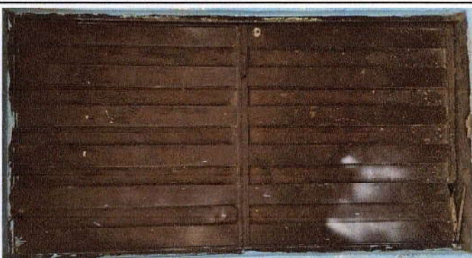
Foto 3: Sustitución de puertas
