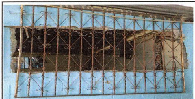
Foto 4: Mantenimiento de balcones de metal.
