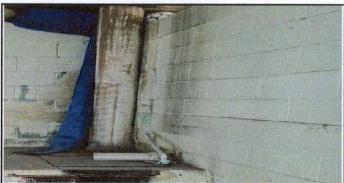
11. Sustitución de chimenea.
