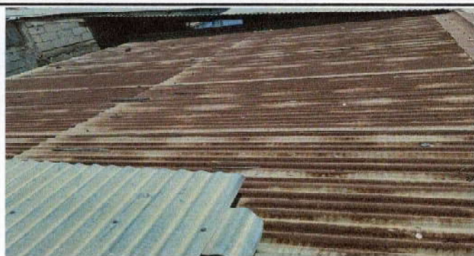
Foto1: Sustitución de lámina.
