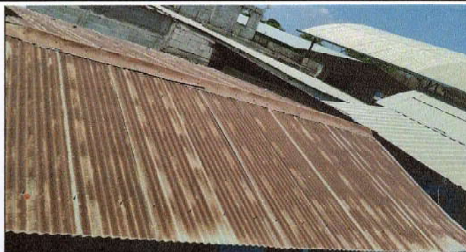
Foto 2: Sustitución de capotes.
