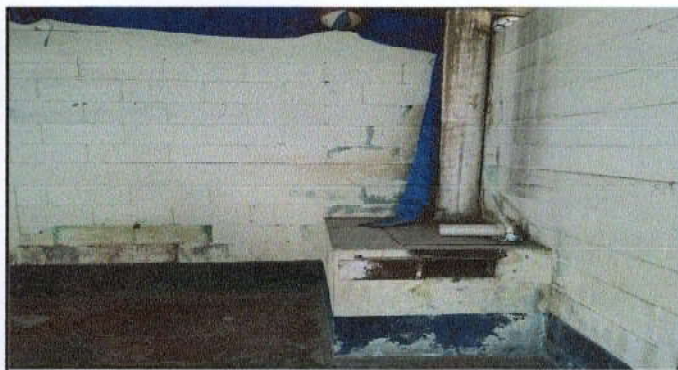
10. Sustitución de plancha.
