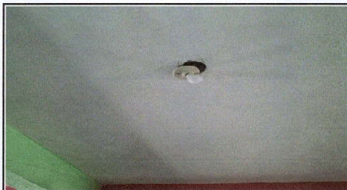
8. Sustitución y reparación de sistema eléctrico.
