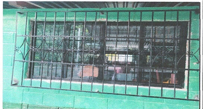
Foto 4: Mantenimiento de balcones de ventanas finalizado.
