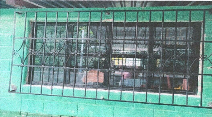
Foto 3: Sustitución de ventanas de metal finalizado.
