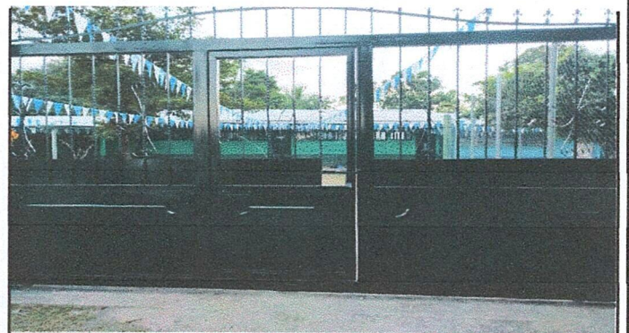
Foto 6: Mantenimiento de portón finalizado.
