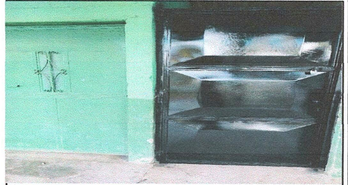
Foto 2: Mantenimiento a estructura (lijado, sujeciones, aplicación de pintura) finalizado.
