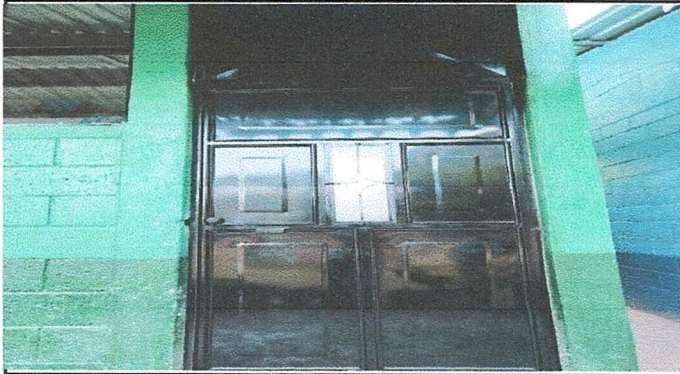
Foto 1: Sustitución de puertas de metal finalizado.
