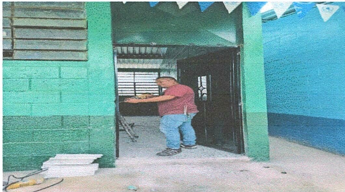
Foto1: Sustitución de puertas de metal en ejecución.
