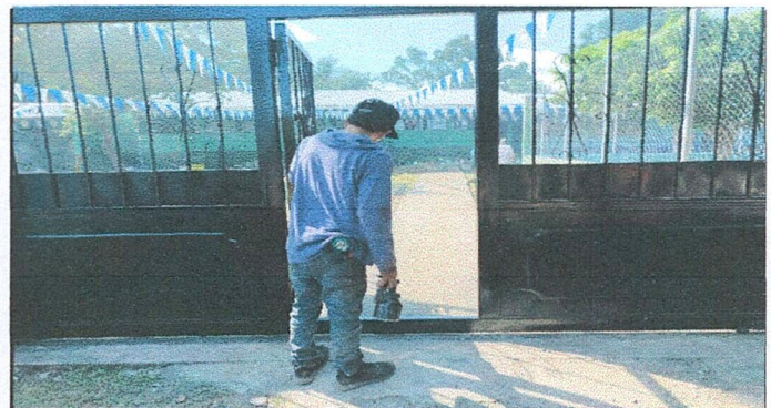
Foto 6: Mantenimiento de portón en ejecución.
