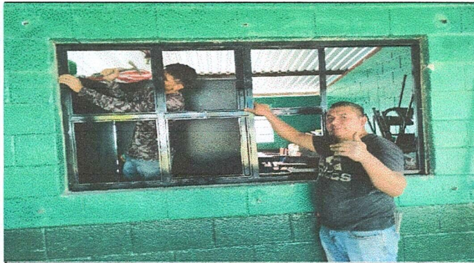
Foto 3: Sustitución de ventanas de metal en ejecución.
