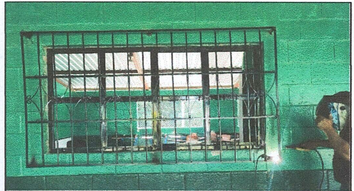
Foto 4: Mantenimiento de balcones de ventanas en ejecución.
