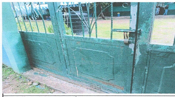
Foto 6: Mantenimiento de portón
