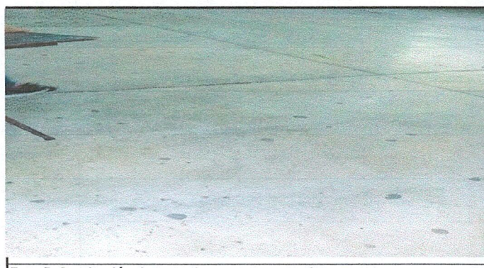
Foto 5: Sustrucción de torta de cemento a granito.
