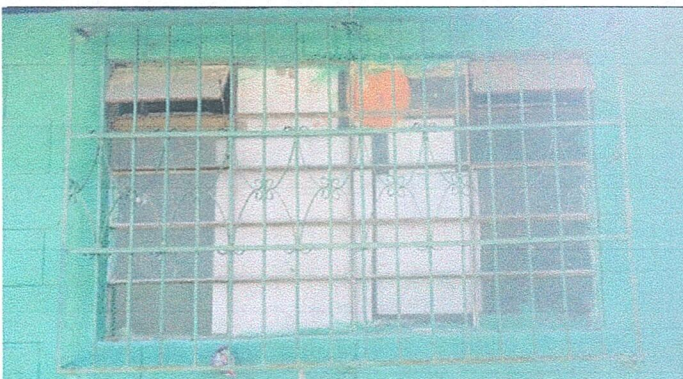
Foto 3: Sustrucción de ventanas de metal.
