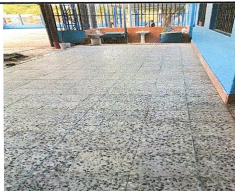
Foto 4: Sustitución de piso de granito. (corredor) ya instalado
