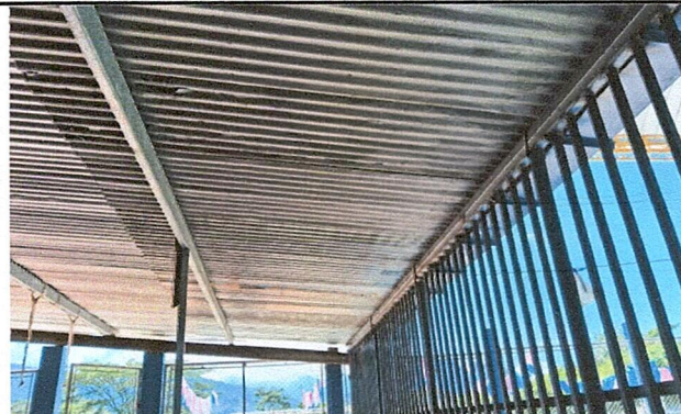
Foto 2: CUBIERTA DE LÁMINA. ÁREA 2 instalada y elementos de fijación
