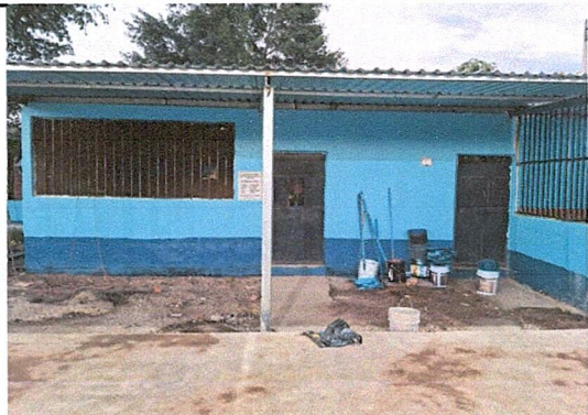
Foto1: CUBIERTA DE LÁMINA ÁREA 1 Instalada y elementos de fijación
