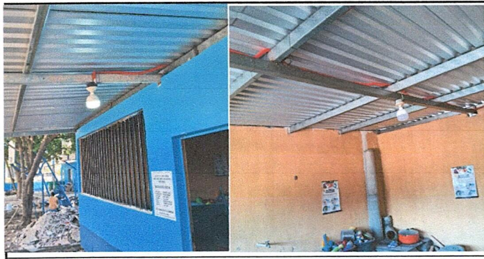
Foto 6: Reparación de Sistema Eléctrico: Instalación de Focos ahorradores y reparación de cableado eléctrico.
