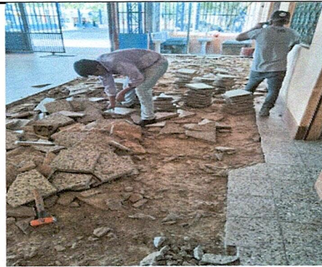
Foto 4: Sustitución de piso de granito en mal estado. (corredor)
