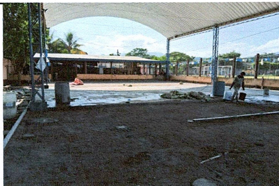
Foto 3: Sustitución de piso de torta de cemento.. Área de la cancha en ejecución.
