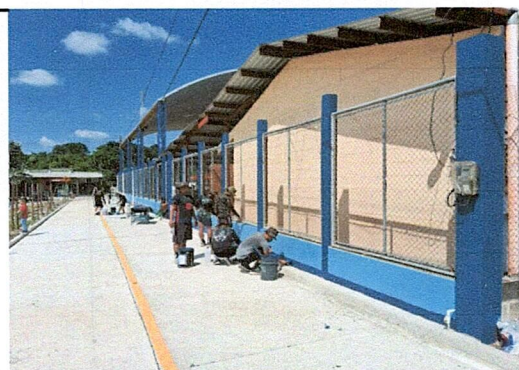
Foto 5: Pintura en muros exteriores e interiores
