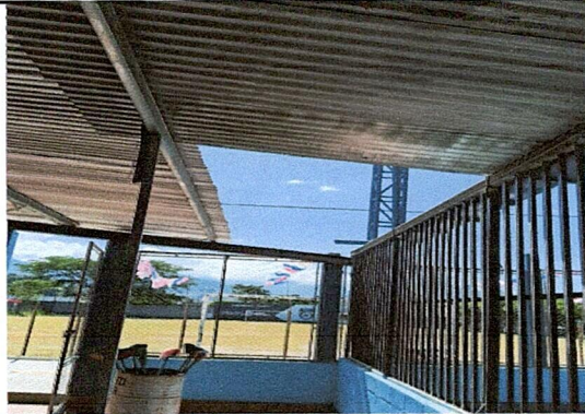
Foto 2: Cambio de lámina y elementos de fijación
