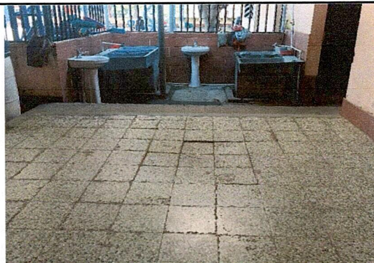
Foto 4: Sustitución de piso de granito. (corredor)
