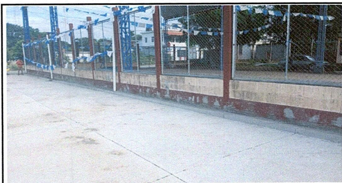
Foto 5: Pintura en muros exteriores e interiores
