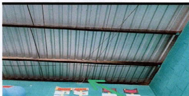
Foto 11: 17 REPARACIÓN DE SISTEMA ELÉCTRICO: 17.11 Reparación de cableado eléctrico: Está en mal estado, está dañado, corroído, desgastado.
