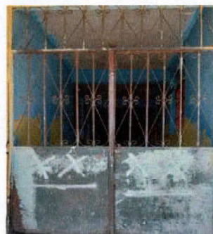
Foto 2: 4. PUERTAS DE METAL: 4.5 Sustitución de portón de metal: Por estar desgastado, no se puede abrir y cerrar bien, esta desbalanceado, oxidado y no tiene chapa y representa peligro por no ser seguro.
