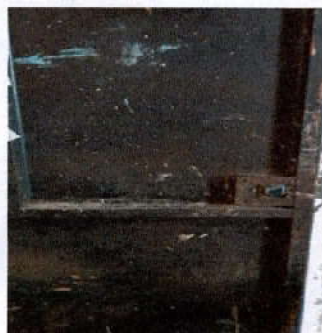
Foto 1: 4. PUERTAS DE METAL: 4.1 Mantenimiento a estructura (lijado, cepillado, aplicación de pintura) Por desgaste de pintura, partes oxidadas 4.2 Sustitución de chapa Yale.
