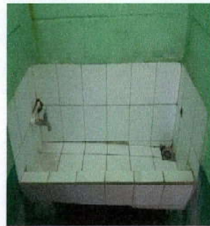
Foto 8: 10.SERVICIOS SANITARIOS Y SUS ACCESORIOS: 10.8 Sustitución de urinal: En mal estado, olores fuertes, manchas.
