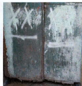
Foto 2: 4. PUERTAS DE METAL: 4.5 Sustitución de portón de metal: Por estar desgastado, no se puede abrir y cerrar bien, esta desbalanceado, oxidado y no tiene chapa y representa peligro por no ser seguro.
