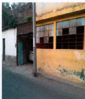
Foto 3: 5. VENTANAS: 5.3 Sustitución de ventanas por metal mas vidrio: En mal estado sin vidrios, representa peligro a la integridad física de los estudiantes y contaminación auditiva por estar a la orilla de la carretera.
