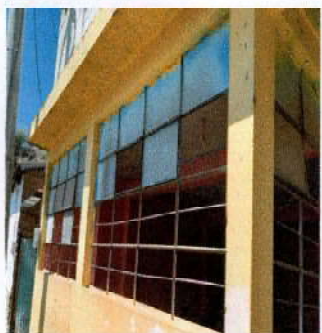
Foto 3: 5. VENTANAS: 5.3 Sustitución de ventanas por metal mas vidrio: En mal estado sin vidrios, representa peligro a la integridad física de los estudiantes y contaminación auditiva por estar a la orilla de la carretera.
