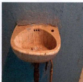
Foto 7: 10.SERVICIOS SANITARIOS Y SUS ACCESORIOS: 10.5 Sustitución lavamanos: Lavamanos fuera de servicio por estar quebrado, tiene grietas, roturas.
