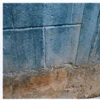
Foto 12: 21 REPARACIÓN DE REPELLO Y CERNIDO DE PAREDES (CUANDO APLIQUE) 21.1 Repello en muro y paredes exteriores e interiores por desprendimiento de repello, descascarado y grietas.
