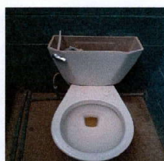
Foto 6: 10. SERVICIOS SANITARIOS Y SUS ACCESORIOS: 10.2 Sustitución de accesorios inodoro (contra llave, tubo de abasto y tanque) baños en mal estado, están deteriorados.
