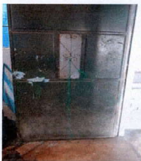
Foto 1: 4. PUERTAS DE METAL: 4.1 Mantenimiento a estructura (lijado, cepillado, aplicación de pintura) Por desgaste de pintura, partes oxidadas 4.2 Sustitución de chapa Yale.
