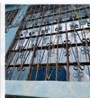
Foto 4: 5. VENTANAS: 5.6 Sustitución de balcones de metal: Daños estructurales, marcos deteriorados, pintura descascarada; representa peligro de hurto por estar a la orilla de la carretera.
