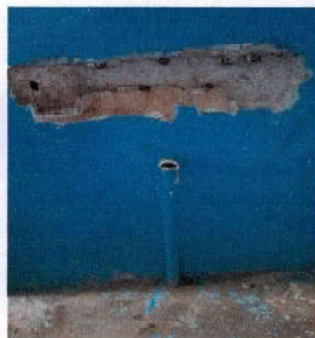
Foto 9: 14. REPARACION DE RED DE DRENAJE Y RED DE AGUA POTABLE: Red de Drenaje:14.3 Sustitución de tubería PVC línea principal aguas negras:Las tuberías de drenaje de baños en mal estado hay fugas, olores
