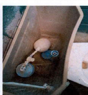
Foto 6: 10. SERVICIOS SANITARIOS Y SUS ACCESORIOS: 10.2 Sustitución de accesorios inodoro (contra llave, tubo de abasto y tanque) baños en mal estado, están deteriorados.
