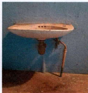
Foto 7: 10.SERVICIOS SANITARIOS Y SUS ACCESORIOS: 10.5 Sustitución lavamanos: Lavamanos fuera de servicio por estar quebrado, tiene grietas, roturas.
