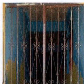
Foto 4: 5. VENTANAS: 5.6 Sustitución de balcones de metal: Daños estructurales, marcos deteriorados, pintura descascarada; representa peligro de hurto por estar a la orilla de la carretera.
