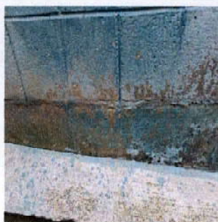
Foto 5: 9. PINTURA EN MUROS EXTERIORES E INTERIORES: 9.1 Pintura en muros exterior e interior: Pintura desgastada, agrietada, descascarada, decolorada.
