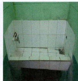
Foto 8: 10.SERVICIOS SANITARIOS Y SUS ACCESORIOS: 10.8 Sustitución de urinal: En mal estado, olores fuertes, manchas.
