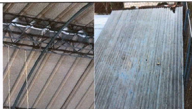
Foto 10: Lámina, capote y elementos de fijación deteriorados y en mal estado.
