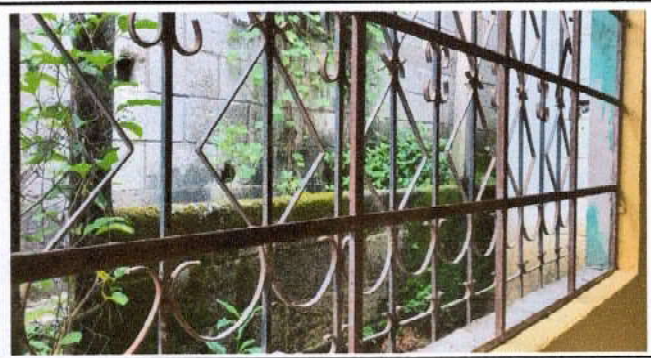
Foto 6: Balcones de metal oxidados y en mal estado.
