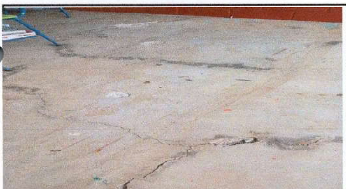
Foto 2: Piso de torta de cemento en mal estado.
