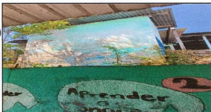
Foto 8:Repello de paredes de sanitarios deteriorados.
