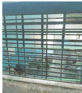
Foto 2: Balcones de metal instalados
