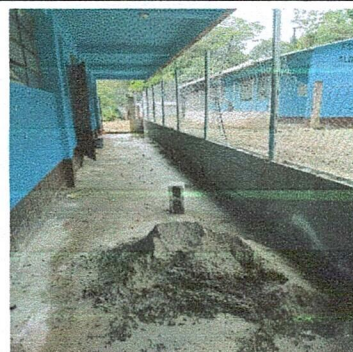
Foto 4: Sustitucion de tubo galvanizado con malla
