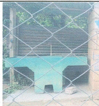
Foto 10: SUSTITUCION DE PILA DE PLASTICO DE DOS LAVADEROS EN MAL ESTADO
