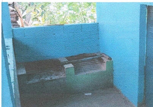
Foto 7: INSTALACION DE AZULEJO EN ESTUFA RURAL
