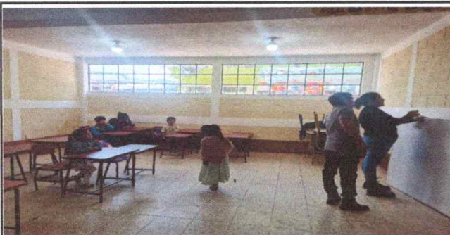
Foto 5: finalización de pintura en muros interiores
