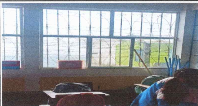
Foto 3: finalizacion de estructura de metal de ventana
