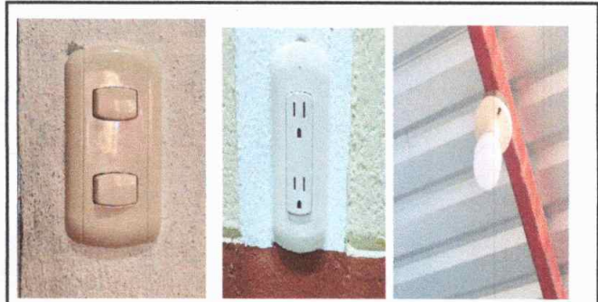
Foto 6: finalización de plafoneras y sustitución de interruptores dobles
