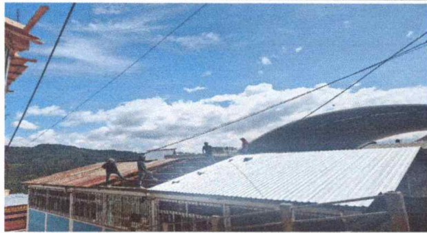
Foto1: trabajando con la colocacion de la lámina
