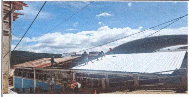
Foto 2: colocación del capote
