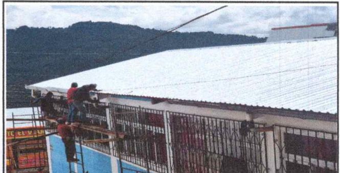
Foto 4: instalación de canal de metal y sustitución de soporte o pescante de metal para canal
