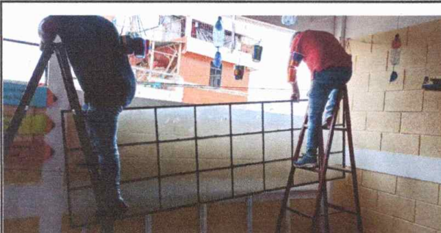
Foto 3: instalación de de ventana
