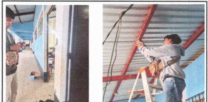
Foto 6: instalacion de plafoneras y sustitución de interruptores dobles
