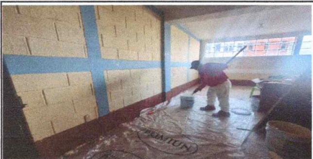
Foto 5: trabajando pintura en muros interiores
