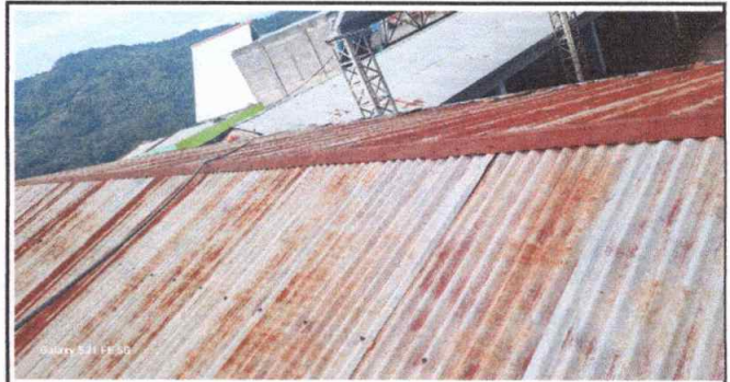
Foto 2: sustitucion de capote
