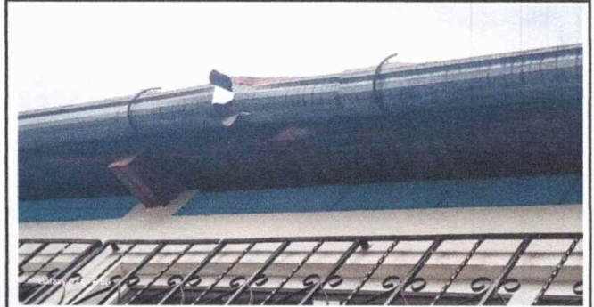
Foto 4: Sustitucion de canal de metal y Sustitución de soporte o pescante de metal para canal
