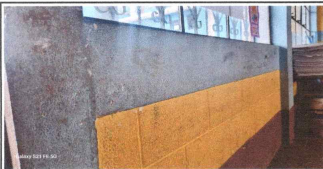
Foto 5: Pintura en muros interiores
