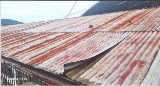
Foto 1: Sustitución de lámina
