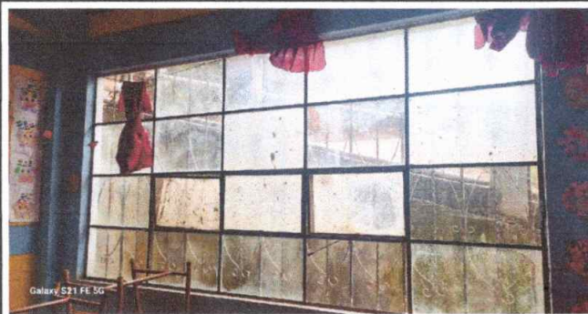
Foto 3: Sustitucion de estructura de metal de ventana
