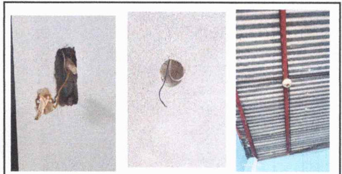
Foto 6: Sustitucion de plafoneras y Sustitución de interruptores dobles
