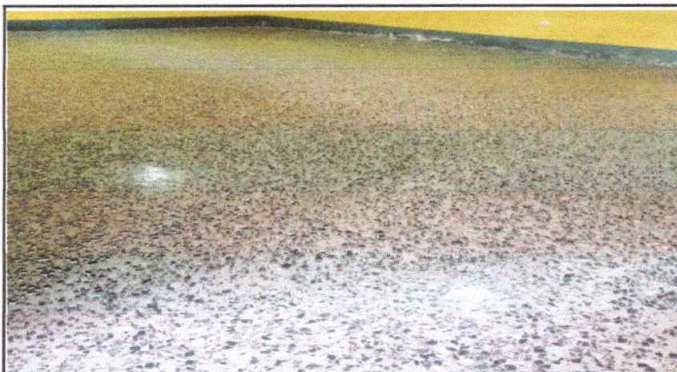
Foto1: Instalacion de piso en el primero y segundo nivel
