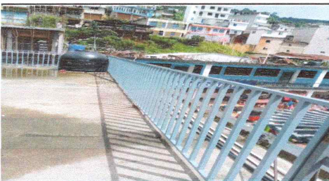
Foto 3: Fabricacion e instalacion de balcones.
