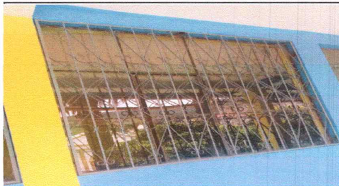
Foto 2: mantenimiento de balcones.
