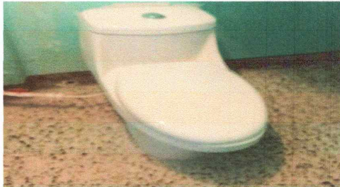
Foto 4: Instalacion de tres inodoros.
