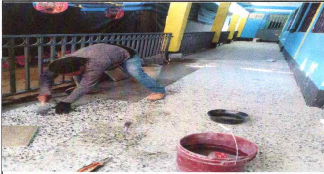
Foto1: Colocación del piso en el primer nivel
