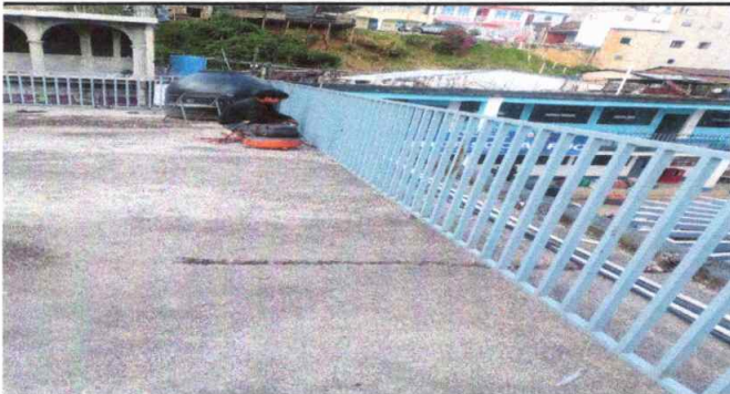
Foto 3: Instalación de baranda
