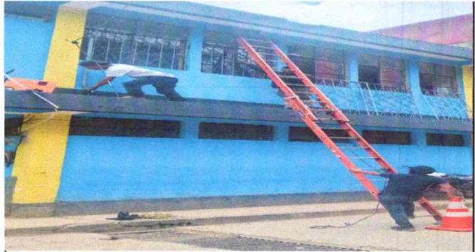
Foto 2: mantenimiento a balcones.
