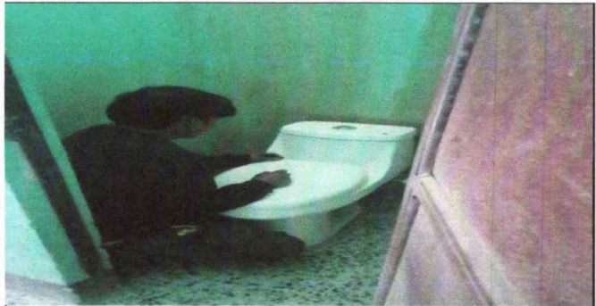
Foto 4: Instalación de inodoros
