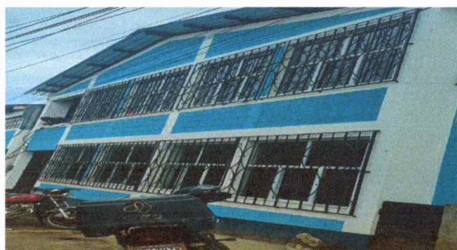
Foto 3: finalización de estructura de metal de ventana
