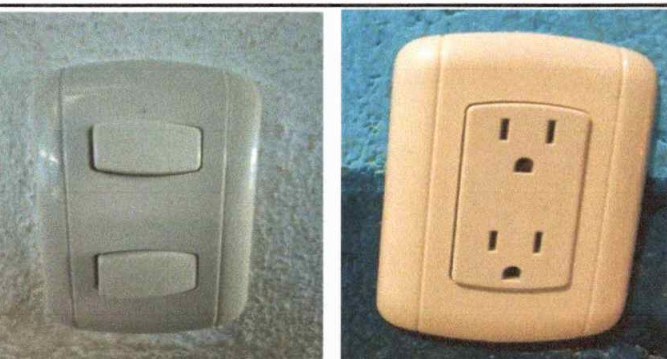
Foto 5: finalización de interruptores dobles
