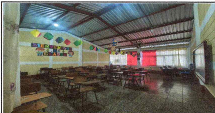
Foto 4: finalización de pintura en muros interiores
