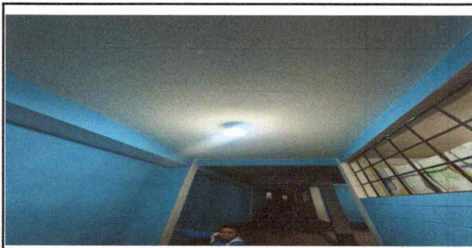
Foto 6: finalización de plafoneras
