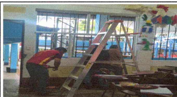
Foto 3: instalación de ventana
