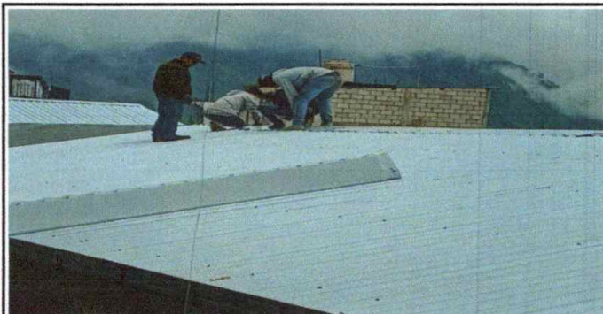
Foto 2: instalación de capote
