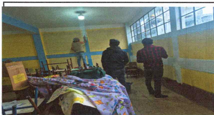
Foto 4: pintura en muros interiores
