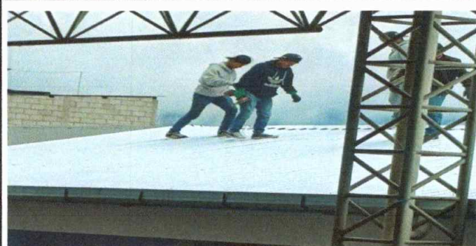
Foto 1: instalación de lámina
