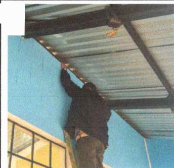
Foto 5: instalación de interruptores dobles
