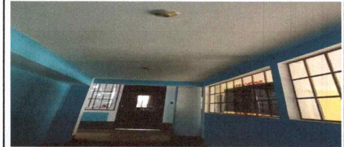
Foto 6: Sustitucion de plafoneras
