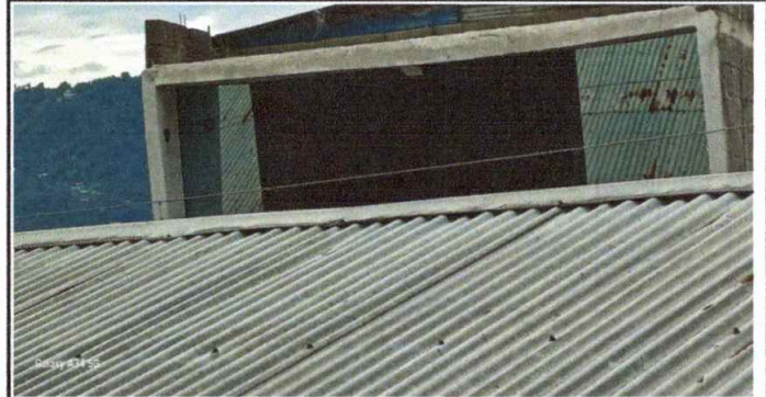
Foto 2: sustitucion de capote de lámina
