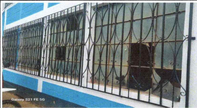
Foto 3: Sustitución de estructura de metal de ventana
