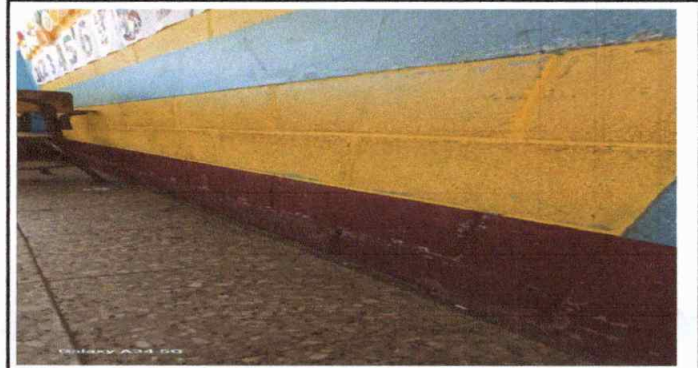
Foto 4: Pintura en muros interiores
