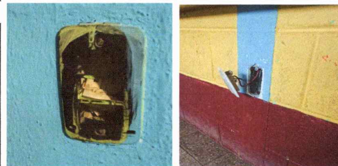
Foto 5: sustitucion de interruptores dobles
