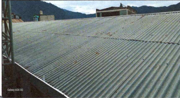
Foto 1: sustitución de lámina
