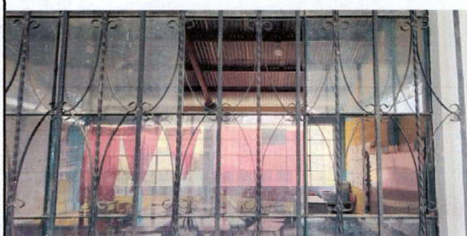
Foto 2.1: Sustitución de vidrios
