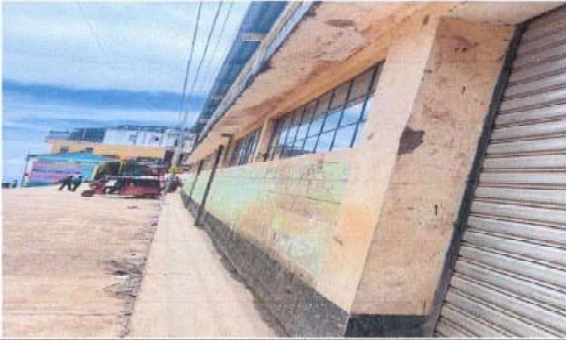
Foto 4.1: Aplicación de pintura en pared exterior
