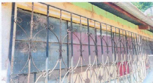
Foto 2.2: Mantenimiento de balcones de metal
