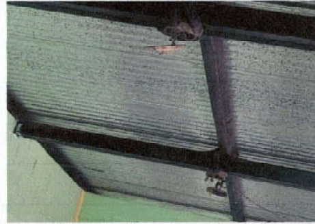
Foto 8: Mantenimiento de energia eléctrica
