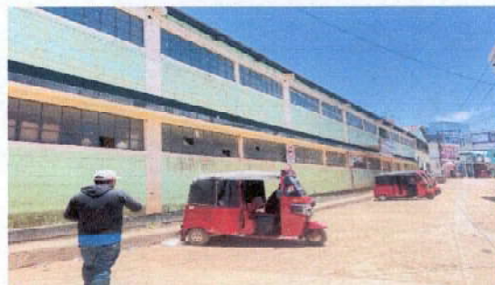
Foto 4: Pintura en muro exterior
