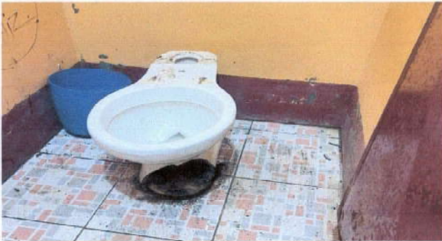
Foto 5: Sustitución de inodoros
