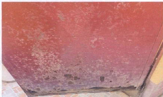
Foto1: Mantenimiento a estructura, lijado y aplicación de pintura en puertas
