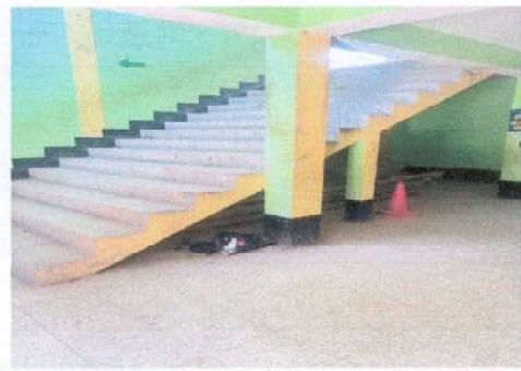
Foto 6: Mantenimiento de baranda
