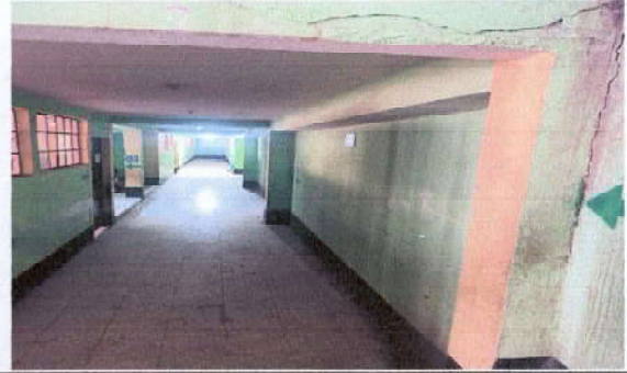
Foto 4.2: Pintura en muro interior
