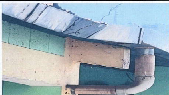
Foto 3: Sustitución de canal de metal
