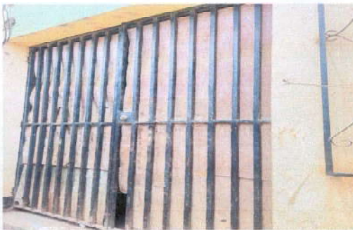
Foto 7: Mantenimiento a porton de metal
