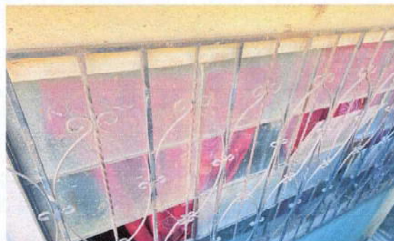
Foto 2.3: Sustitución de ventanas de metal por PVC
