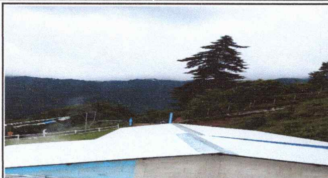
Foto1: Techo del aula del nivel de preprimaria
