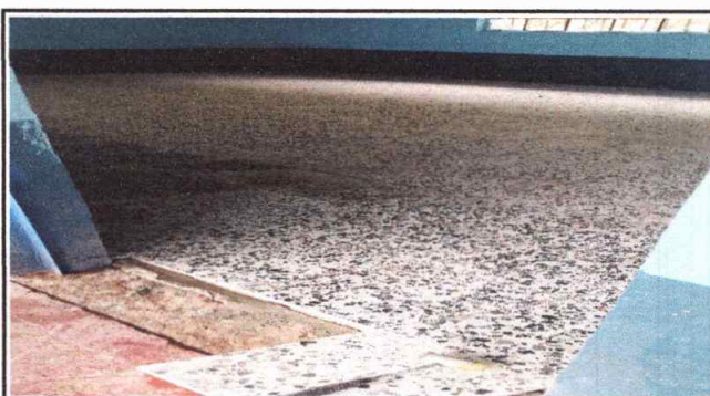
Foto 4: Piso de aulas
