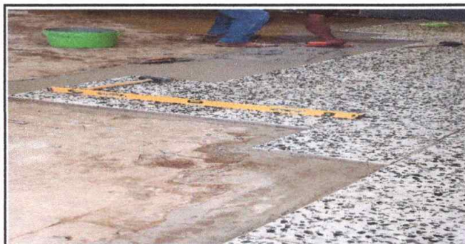
Foto 5: Piso del corredor de la escuela
