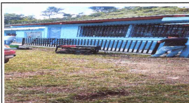
Foto 3: Baranda de la escuela
