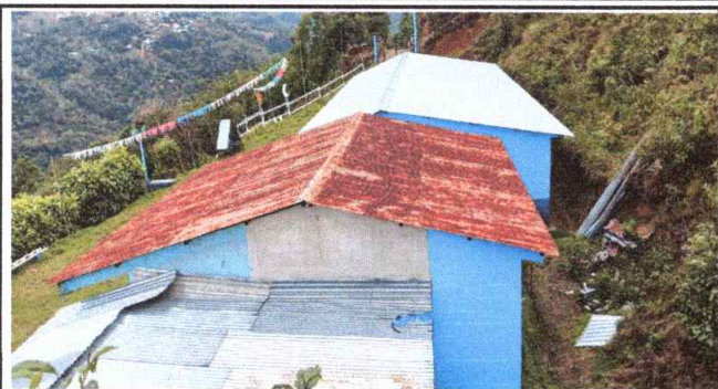
Foto 1: Techo del aula del nivel de preprimaria
