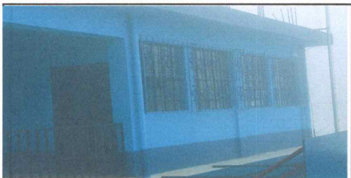
Foto 5: Colocación de balcones terminadas
