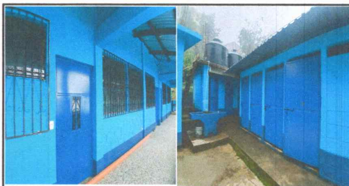
Foto 6: puertas colocada del baño y pintadas del puertas del aulas.
