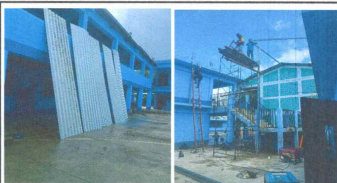
Foto 2: lamina del techo terminada
