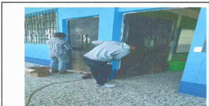
Foto 5: Colocación de balcones terminadas
