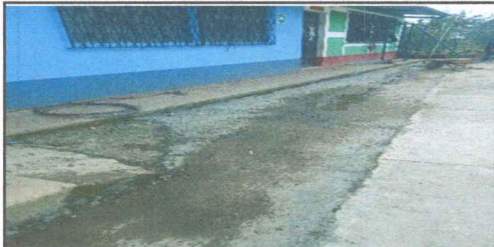
Foto1: Pisos en proceso
