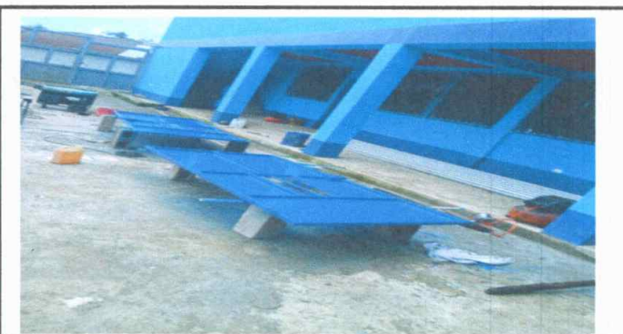
Foto 6: puertas colocada del baño y pintadas del puertas del aulas.
