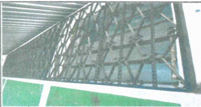
Foto 5: Colocación de balcones
