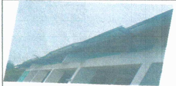
Foto 4: Canales deteriorados
