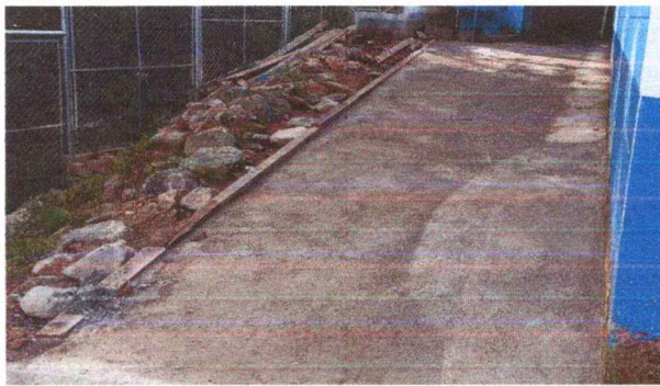
Foto 3: PISO: colocar piso de torta de concreto
