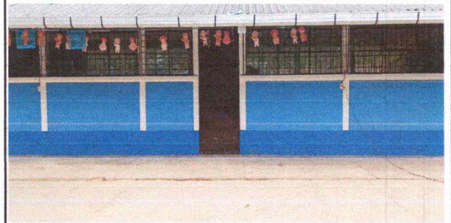
Foto 4: PINTURAS EN MUROS EXTERIORES E INTERIORES: pintar la escuela
