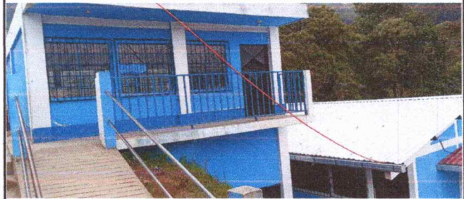
Foto 2: VENTANAS: colocar balcon a las aulas
