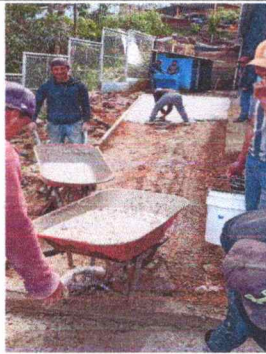
Foto 3: PISO: colocar piso de torta de concreto
