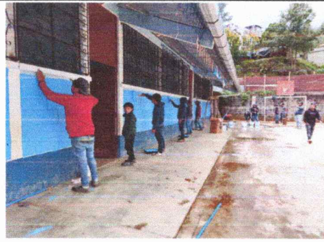
Foto 4: PINTURAS EN MUROS EXTERIORES E INTERIORES: pintar la escuela
