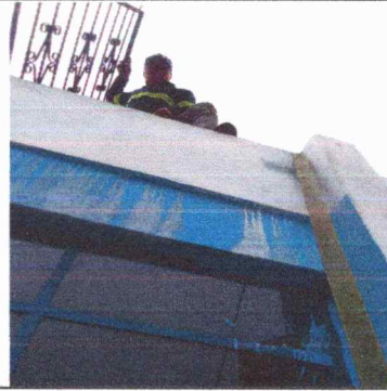
Foto 2: VENTANAS: colocar balcon a las aulas
