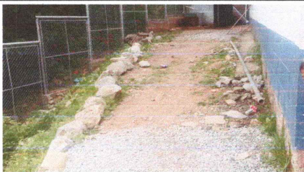
Foto 3: PISO: colocar piso de torta de concreto
