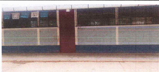
Foto 4: PINTURAS EN MUROS EXTERIORES E INTERIORES: pintar la escuela
