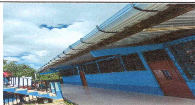
Foto 6: Sustrucción de canales
