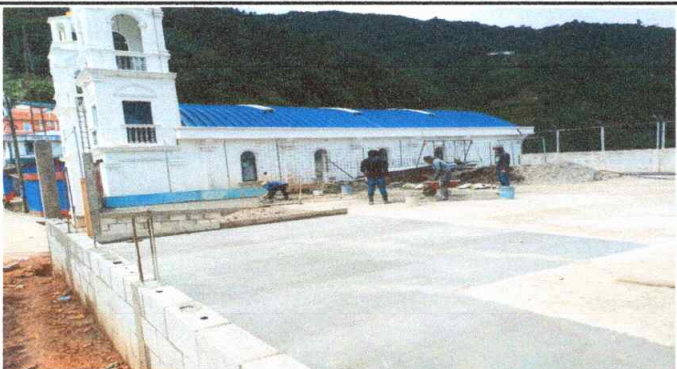
Foto 3: Sustrucción de piso
