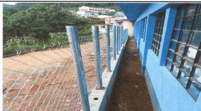
Foto 2: Sustrucción de malla y tubos de metal
